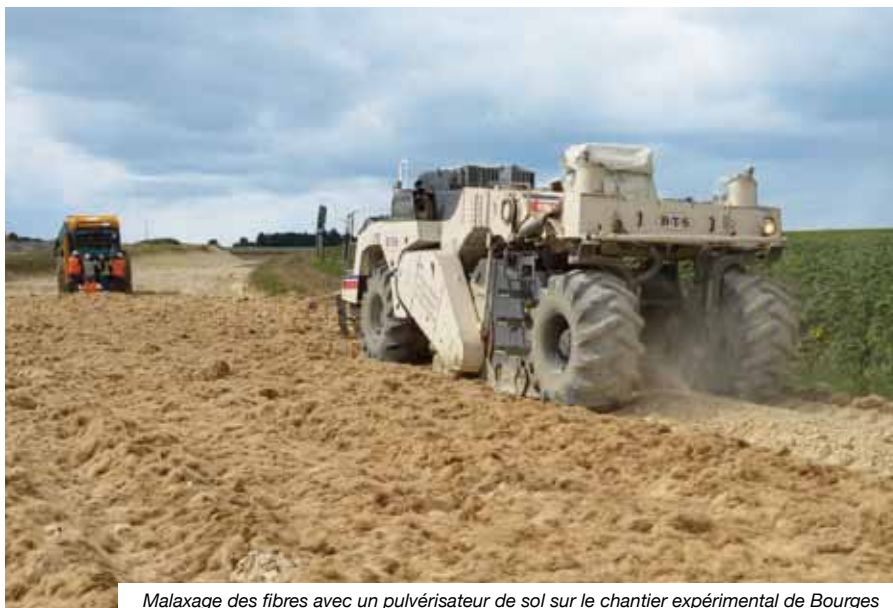
Malaxage des fibres avec un pulvérisateur de sol sur le chantier expérimental de Bourges
