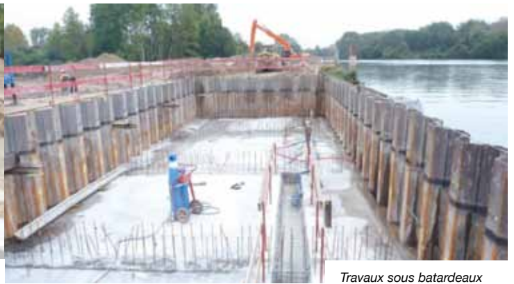
Travaux sous batardeaux
