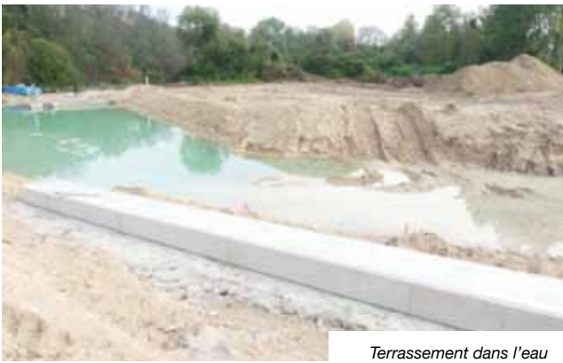
Terrassement dans l'eau
