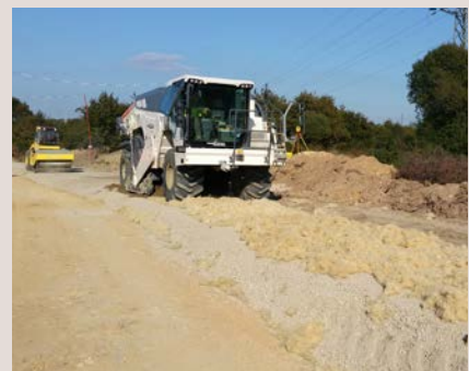
Création de voie communale à Theix avec le procédé SATIS®. Les fibres de chanvre dans les sous-couches permettent une forte réduction des épaisseurs d'enrobés de surface.
