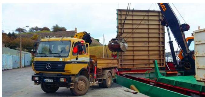
Des travaux soumis à de fortes contraintes. Ici, le déchargement d'un enrobé venant du continent pour un chantier de voirie sur l'île.
