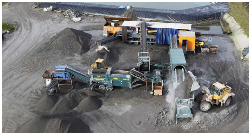
Plateforme mâchefers - Écosite de La Croix Irtelle
