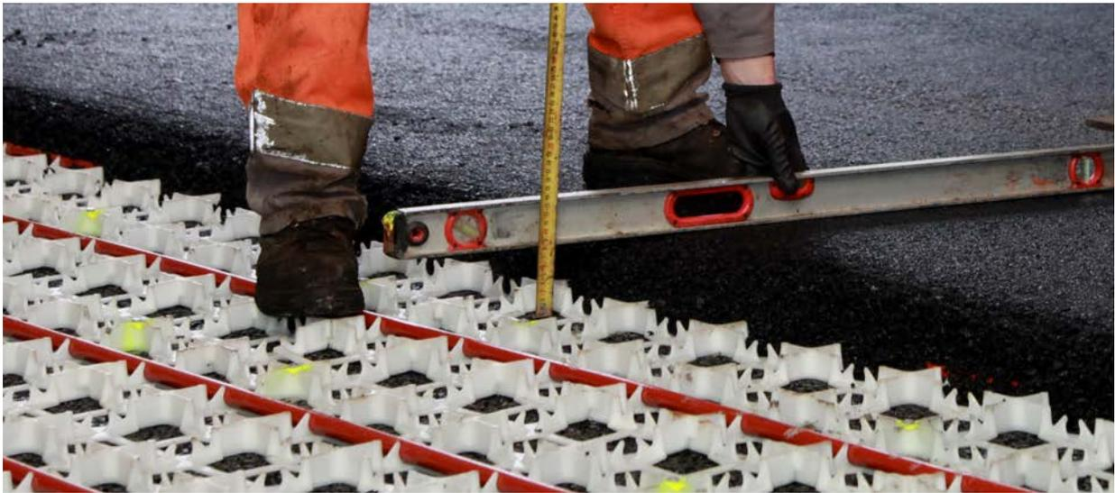
Mise en œuvre des enrobés sur le dispositif de récupération de l'énergie solaire
